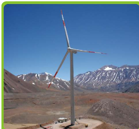
Generador eólico de Veladero
