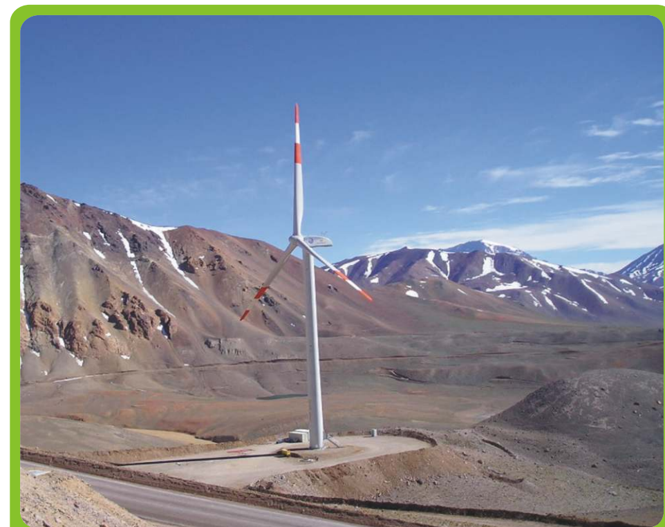
Generador eólico de Veladero
